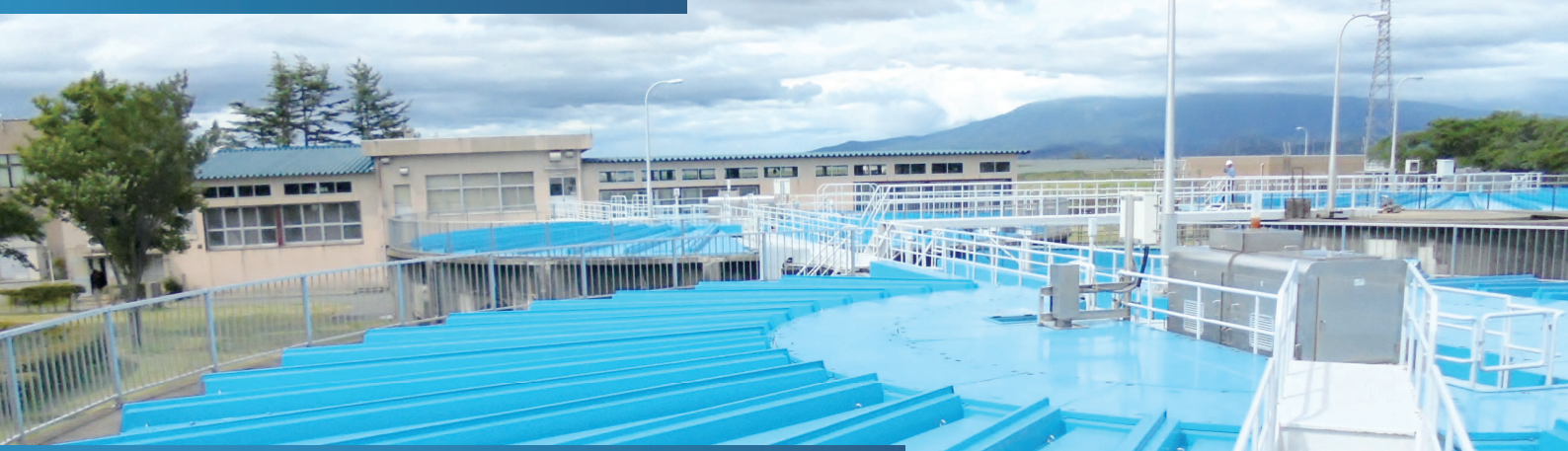
小牧浄水場 高速沈澱池
