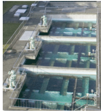
～丸山浄水場ろ過池全景～
