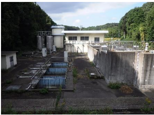
5. 大山浄水場外観
