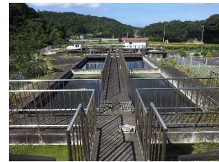
6. 西崎浄水場外観
