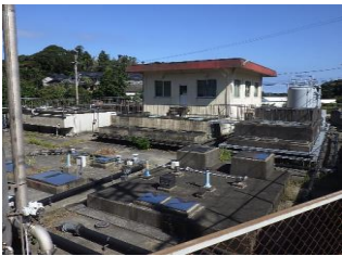
4. 芦辺浄水場外観
